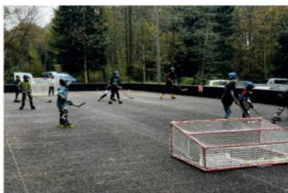
Die alten Stockbahnen, auf denen der Straßenhockey-Club derzeit trainiert, gehört dringend saniert, um Verletzungsrisiken zu minimieren.
